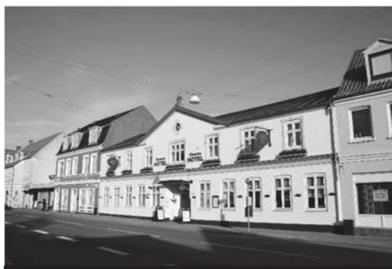
これらの建物には REFA からの熱供給パイプが通じている
