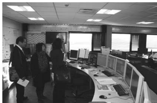
事務所を兼ねたコントロールセンター
