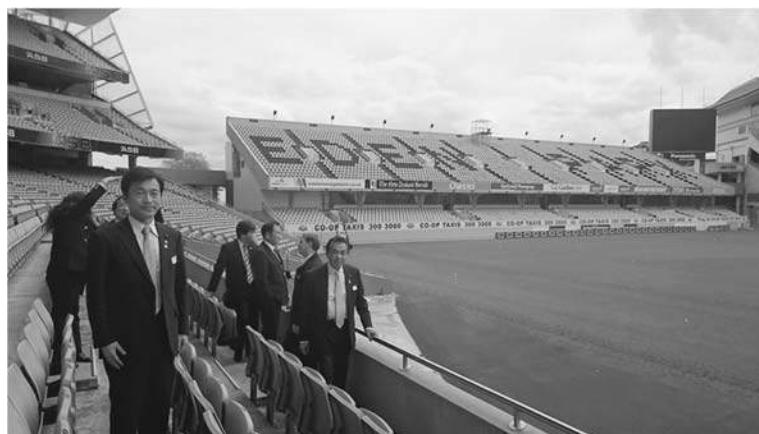
▲EDENPARKの椅子文字スタンドの上部に仮設スタンドを設置し客席を増設、ワールドカップに対応（現在は撤去）
