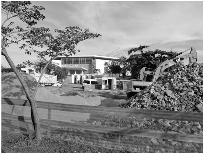
<工事が進むバツハエリア>
