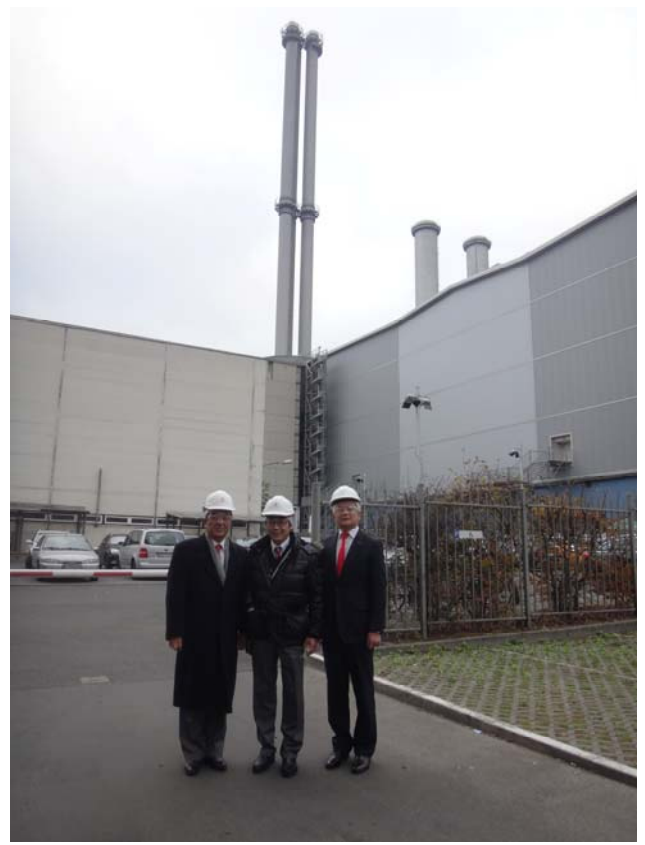
▲ベルリン市内のヴァッテンファ ル社の天然ガス発電所
