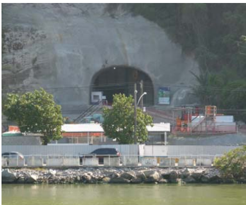
トンネル出口遠景
