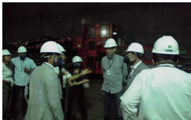
トンネル工事現場で説明を受ける
