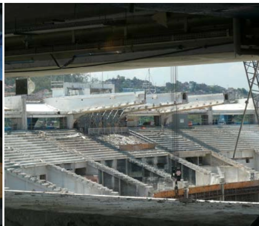
改修工事中の競技場を内部から撮影
