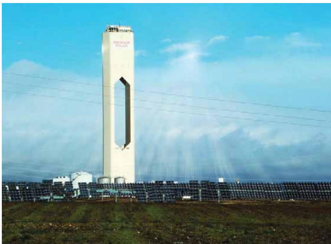
図37 反射鏡によって集められた太陽光線を受けるタワー
