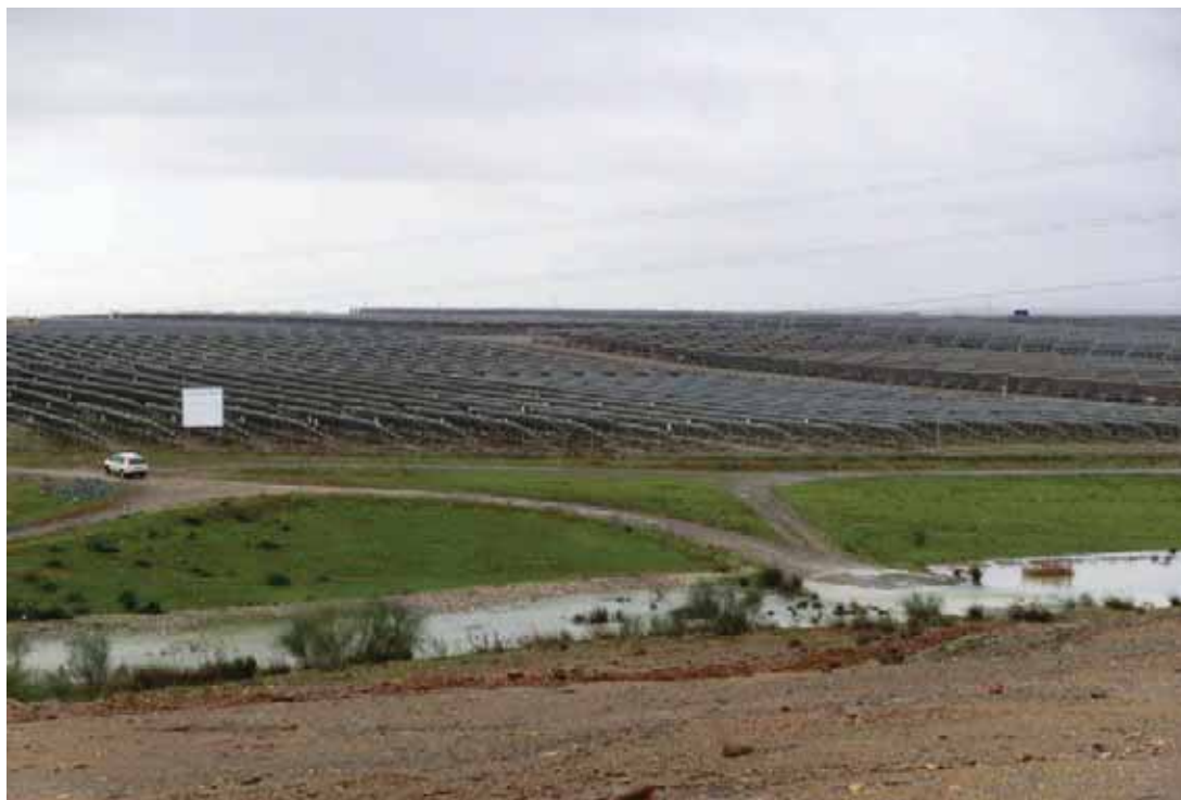
図 36 辺り一面に敷き詰められたソーラーパネル
