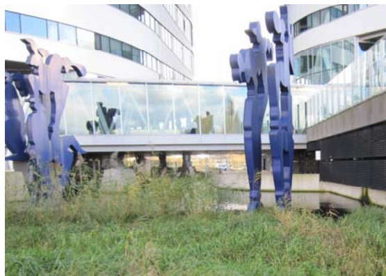
ビル前にある雨水の貯水池で水位を調整
