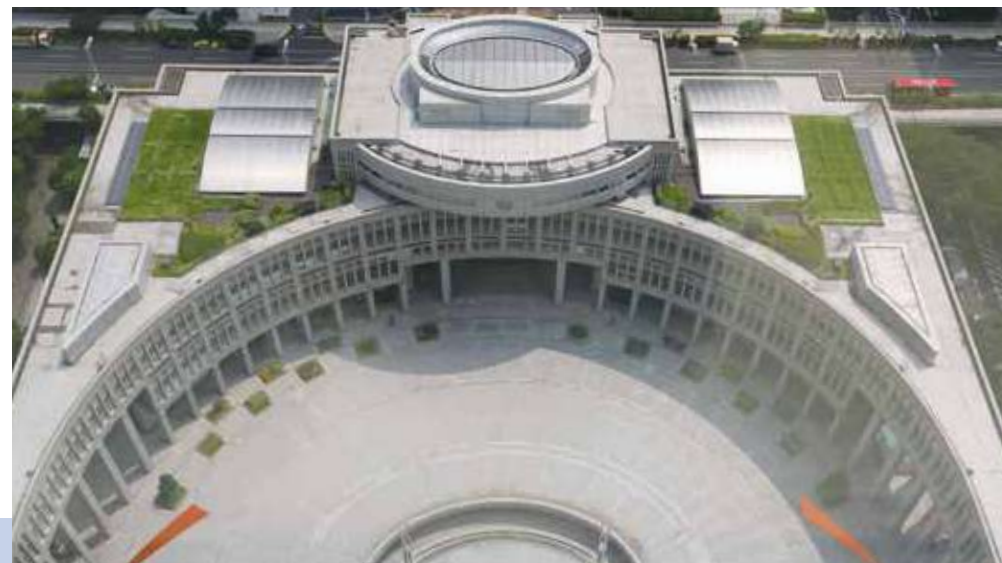
東京都議会議事堂の屋上緑化と太陽光発電設備
